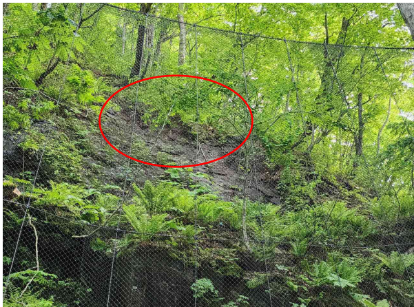
36.11～36.14kp付近(上り線) (3/4): (1/4)①の拡大 直高13m、奥行き25mに不安定な転石(φ30～50cm位)が視られる。ネットで応急対策している。
